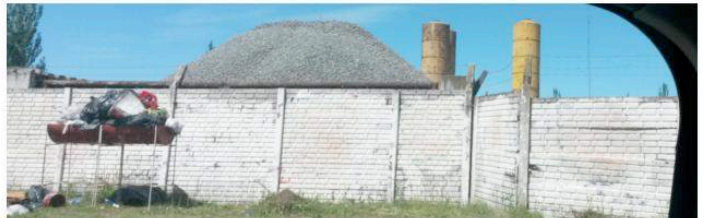
305 (fabrica de cemento)
